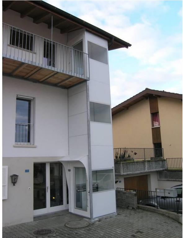
Liftschacht unter Dachschräge eingepasst, nachträglicher Einbau
