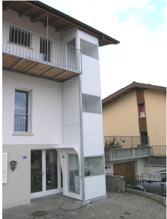
Zugang zu oberer Wohnung über den Balkon
